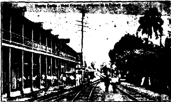
PUERTO CORTÉS.—HOTEL COSENZA Y COMIENZO DE LA PRIMERA AVENIDA.
