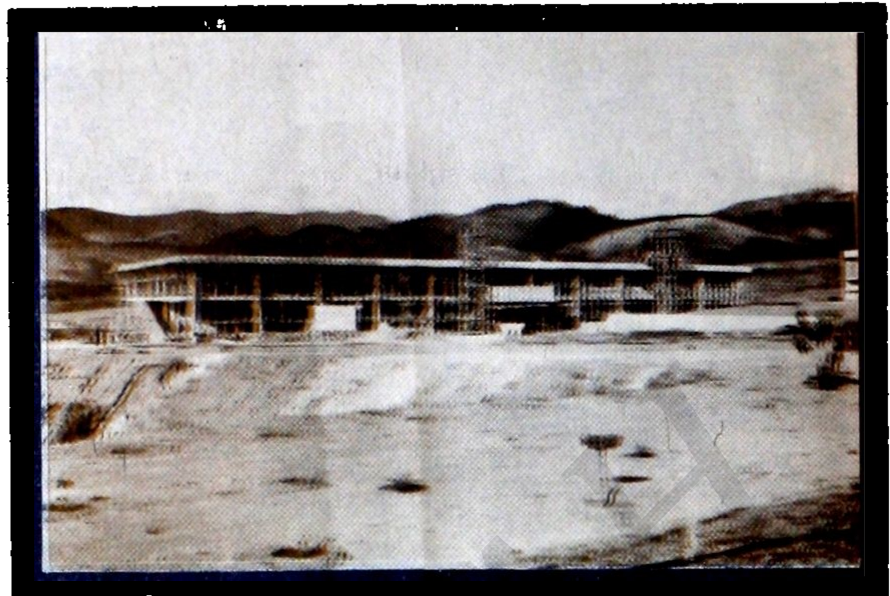
Este nuevo edificio en construcción completará el complejo de laboratorios que está siendo montado por la Universidad para las carreras técnicas.
