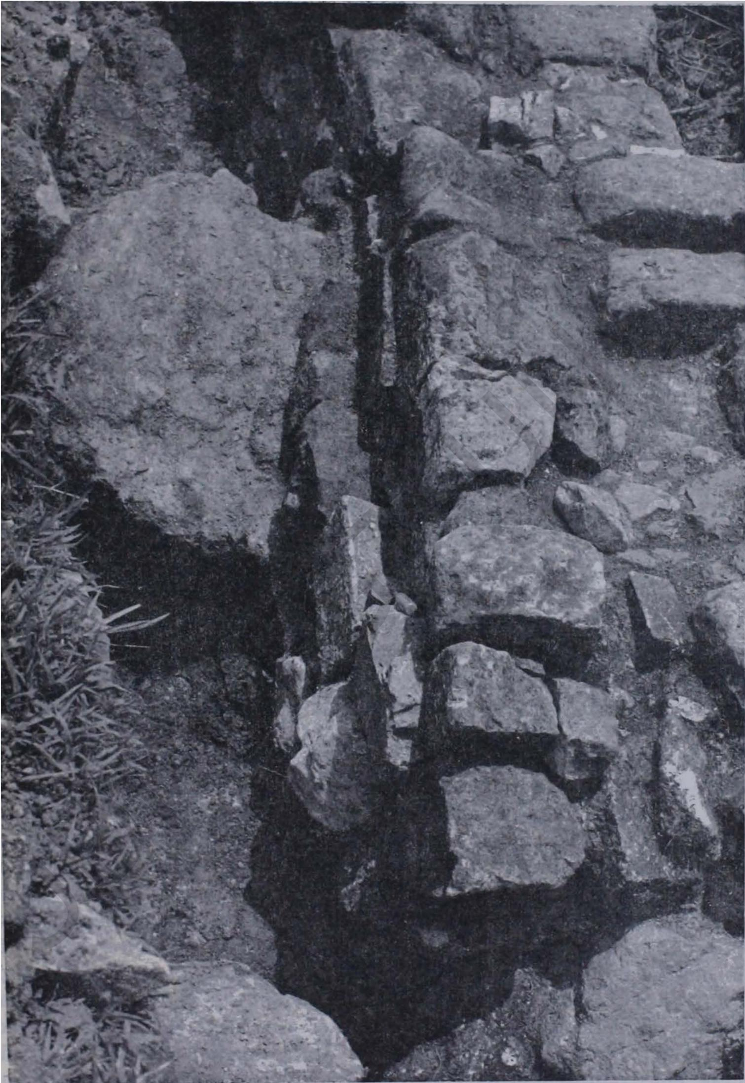
**Figura 4.** Vista de la parte superior y trasera del muro. Nótese el estante saliente. La represa está anclada en el gran peñasco que se extiende debajo del muro.
