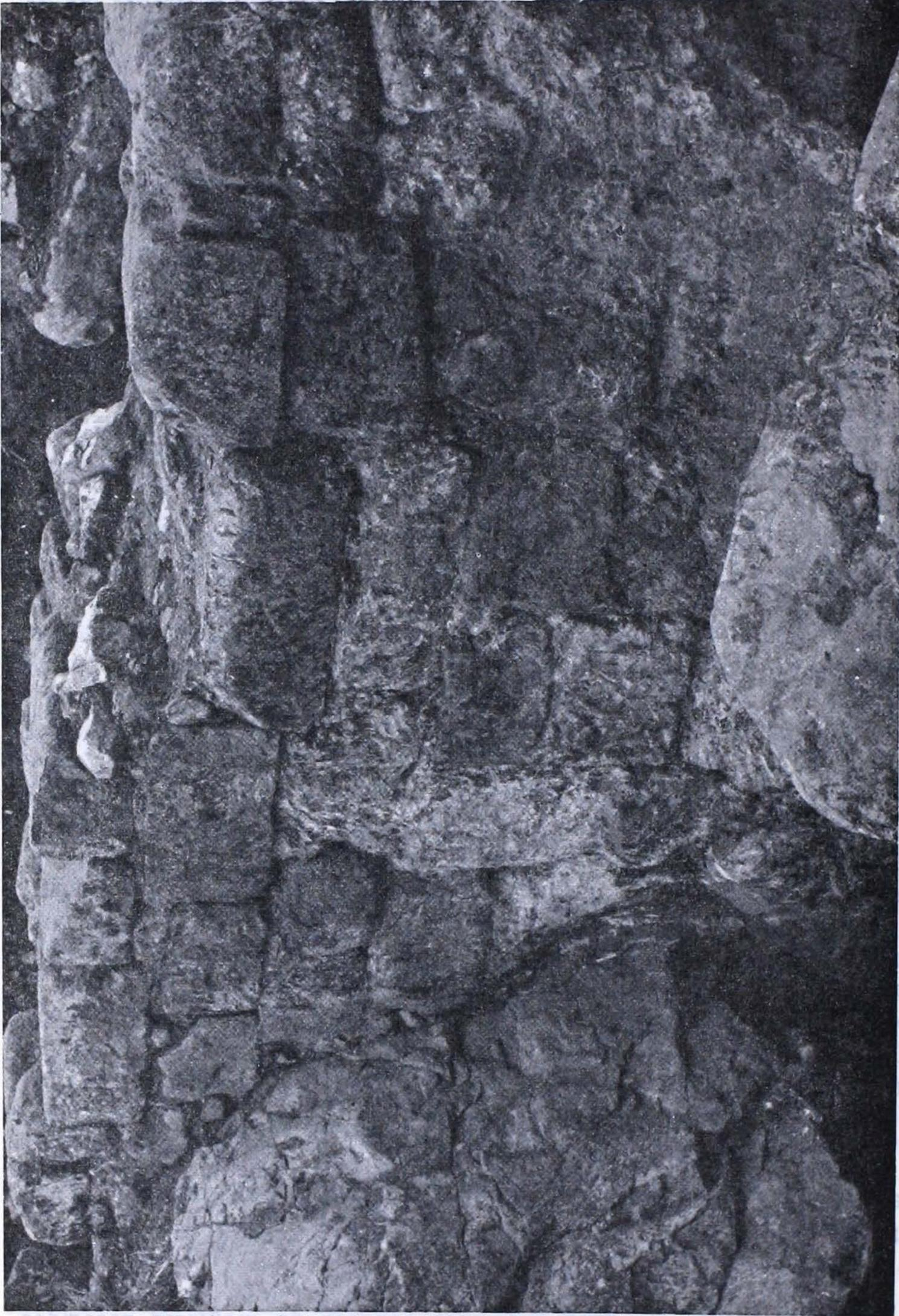
Figura 3. Toma de acercamiento del muro frontal. Nótese el desagüe en la parte superior central del muro. Nótese también el anclaje del lado Sur del muro en unas piedras salientes.
