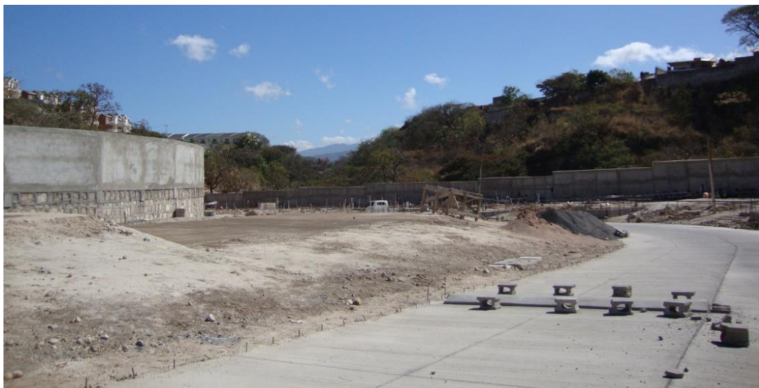
Cuarta etapa, construcción de 66 villas. Foto Ivonne Chain, 2012
