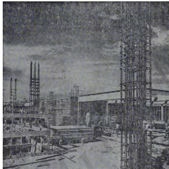
COLUMNAS DE ACERO REFORZADAS ESTAN SIENDO LEVANTADAS EN EL PROCESO DE CONSTRUCCION DEL NUEVO EDIFICIO DE LA COMPAÑIA DE PRODUCTOS FARMACEUTICOS REXALL. DESPUES DE 43 AÑOS DE ESTAR INSTALADAS EN BOSTON LAS OFICINAS DE ESTA COMPAÑIA SERAN TRASLADADAS A LA CIUDAD DE LOS ANGELES.
