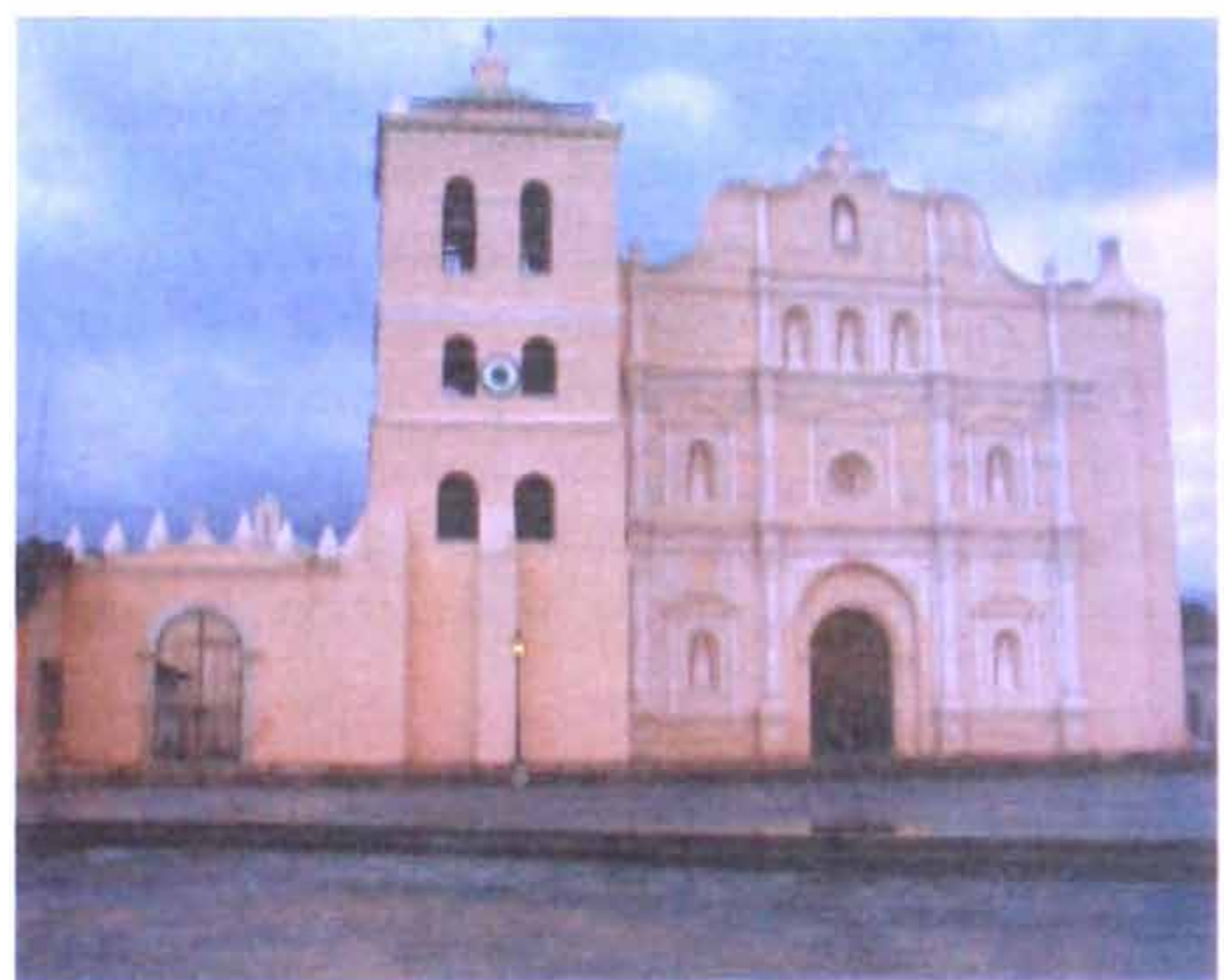
Figura 18 y 18 a. Fachada de la Catedral antes y después de la restauración integral (Ver listado de figuras)
