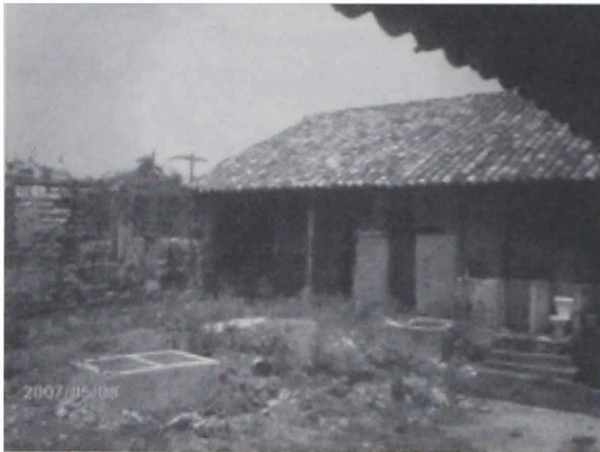
Servicios sanitarios y pilas construidos. Posteriormente.
