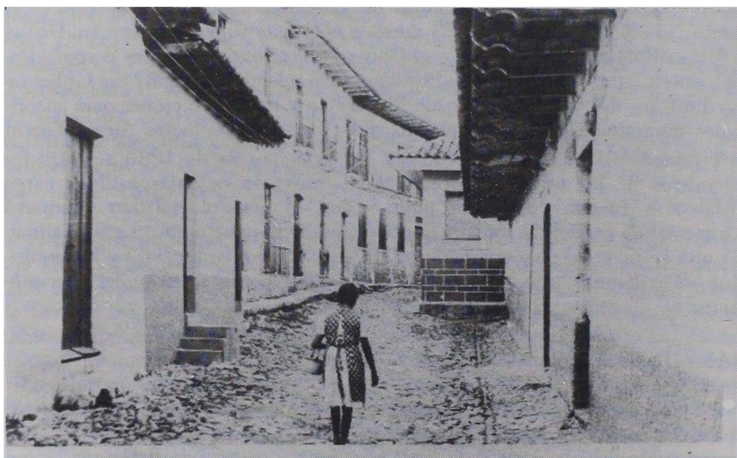
Fig. 3 Casa de la Familia Fortín, fachada principal lado Este, vista de Sur a Norte. CORTESIA: Abog. Donato Fortín.
