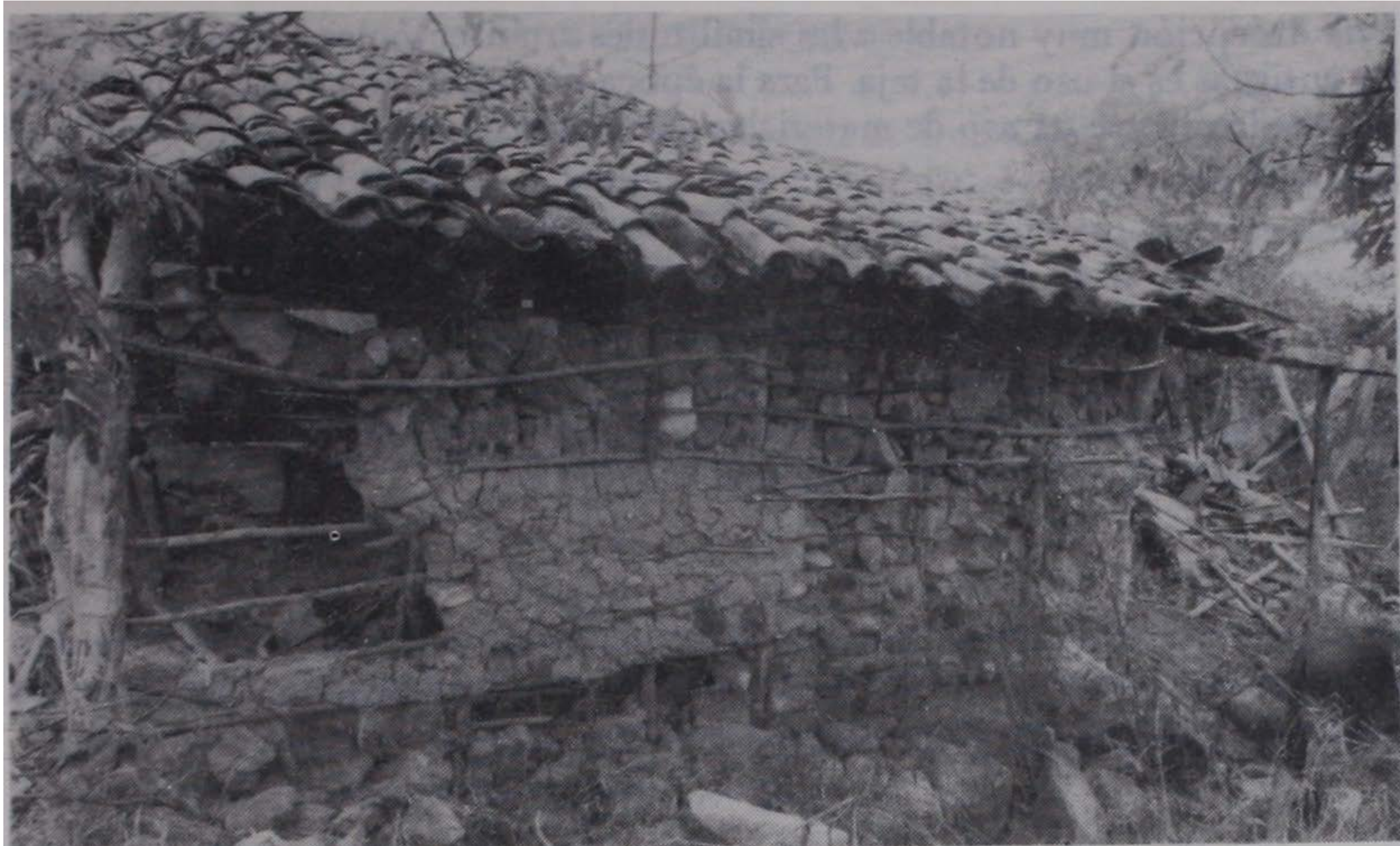
Fig. 9 Pared exterior con sus materiales de construcción expuestos
