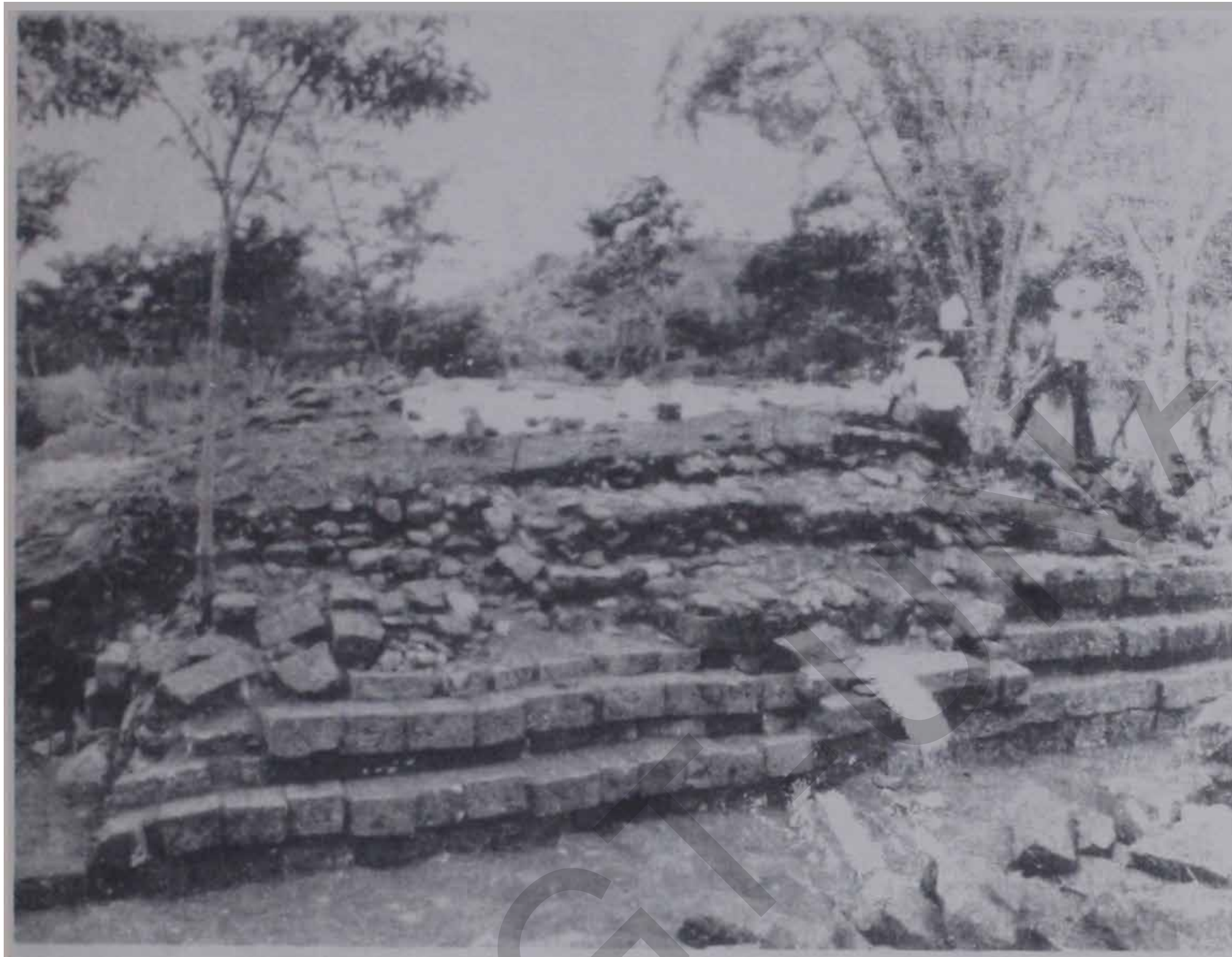
Foto 1. Estructura 189, vista hacia el oeste.
