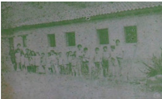
Tiene construcción sólida y con amplias ventanas por donde entra el aire puro del campo. Nuestros y niños posan ante nuestra cámara. Fue ampliada a un costo de L. 2.500.00.
