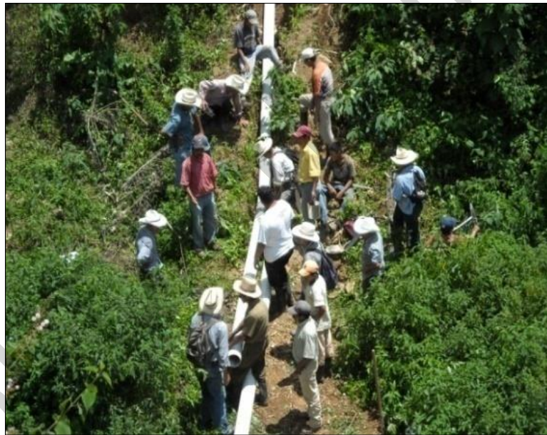
Figura 37. Instalación de Sistemas de Riego en el territorio de Belén Gualcho
