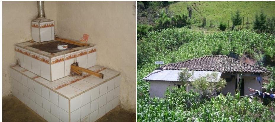
Figura 38. Ecoestufas y paneles solares
