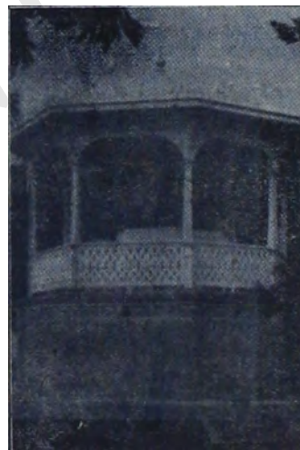
KIOSKO del Parque Valle, inaugurado el 1º de Febrero de 1917 y remodelado por la Municipalidad que presidió el Gral. Rubén Núñez Romero en 1929.
