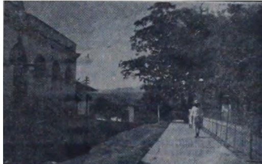
Costado Sur del Parque Valle y fachada del Cuartel principal
