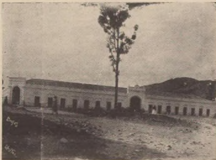
MERCADO SAN ISIDRO DE COMAYAGUELA, FRENTE NORTE. RECONSTRUIDO EN 1925
