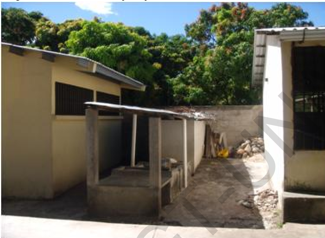
Fotografía No. "9" muestra el espacio para la construcción del modulo sanitario
