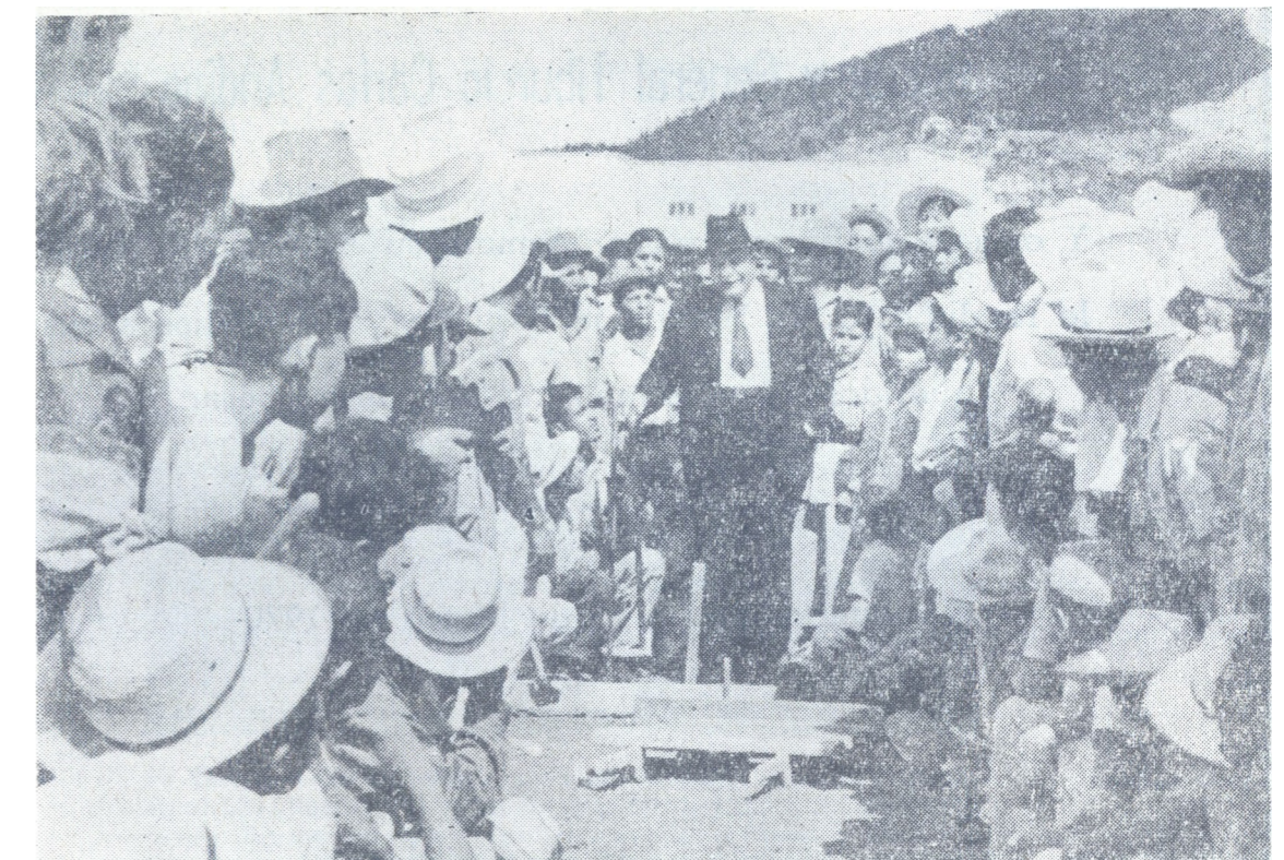
El Dr. y Gral. Tiburcio Carías A., Rodeado de los trabajadores en el Estadio, en construcción
