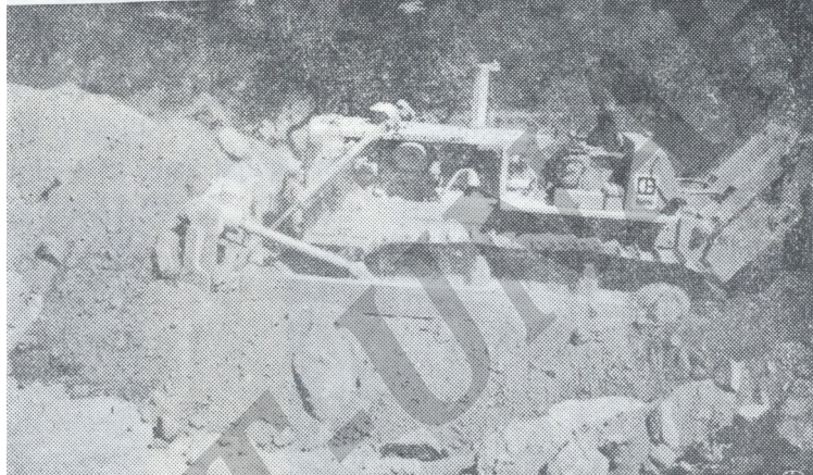
Tractor D-8 ejecutando un trabajo de movimientos de tierras
