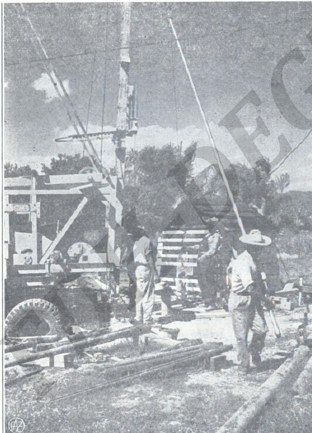
**Operadores de uno de los equipos de perforación colocando la tubería en un pozo de más de 500 pies de profundidad.**
