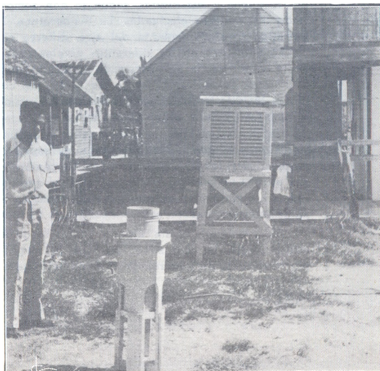
Típica estación Termo-Pluviométrica. El Gobierno tiene establecidas más de 15 estaciones de esta clase en diferentes lugares del país.
