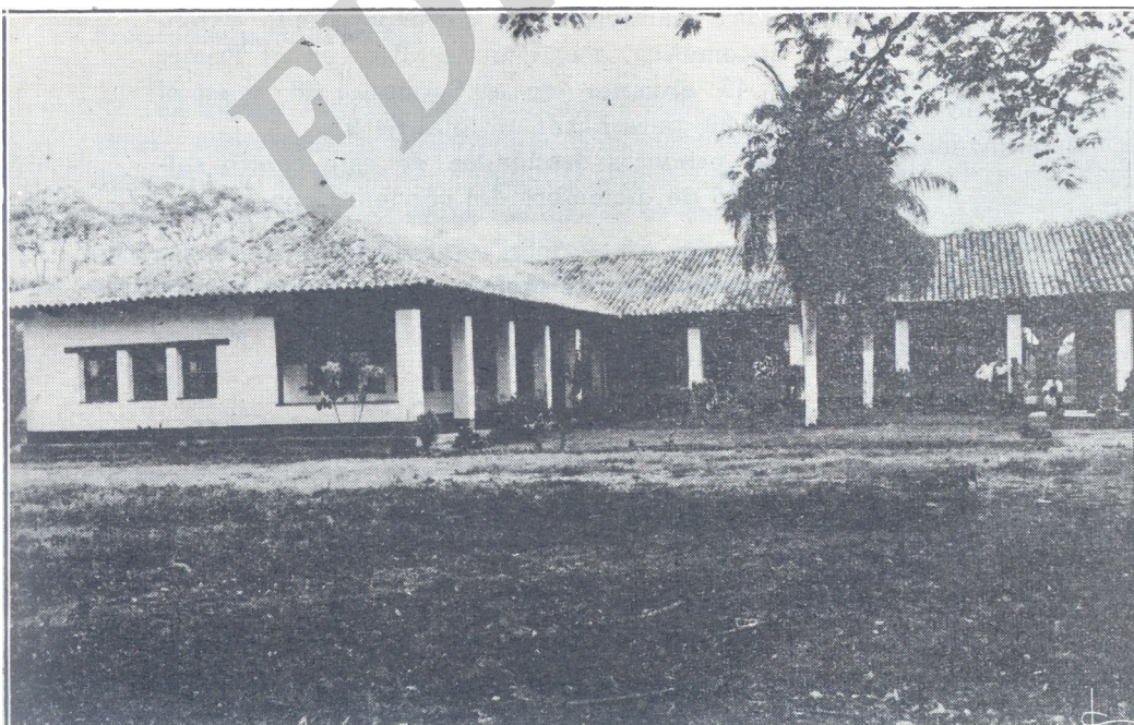
Vista del edificio principal de la Escuela Granja Demostrativa de Catacamas.
