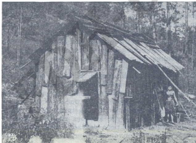
De los desperdicios de la explotación de nuestros bosques, el campesino hondureño construye su habitación en el lugar donde otrora fuera poseedor de una incalculable riqueza.—H. H. C.
