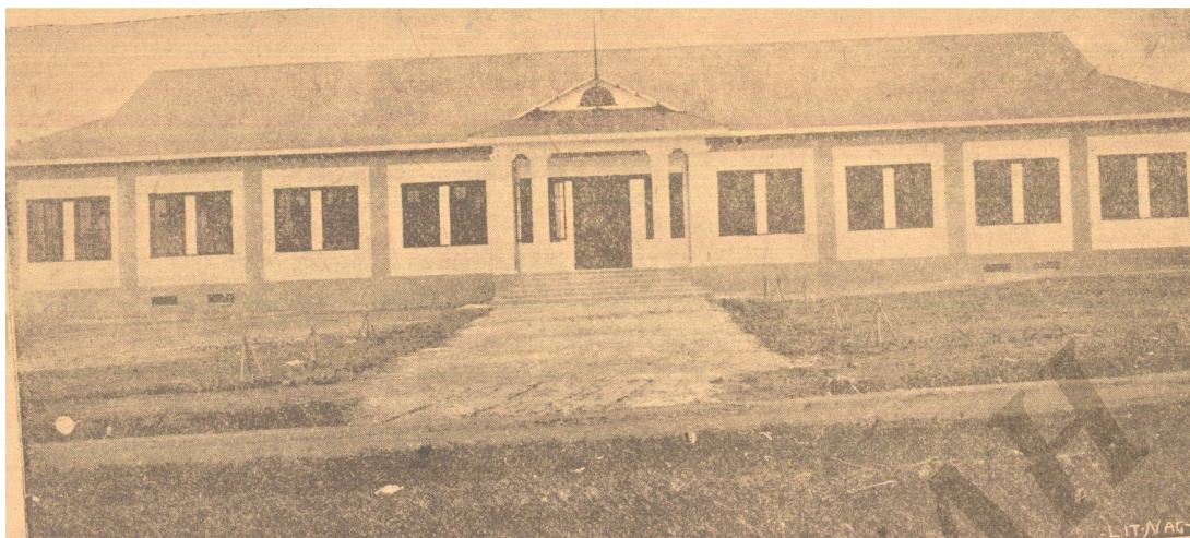
Edificio de la Escuela Primaria de San Pedro Sula
