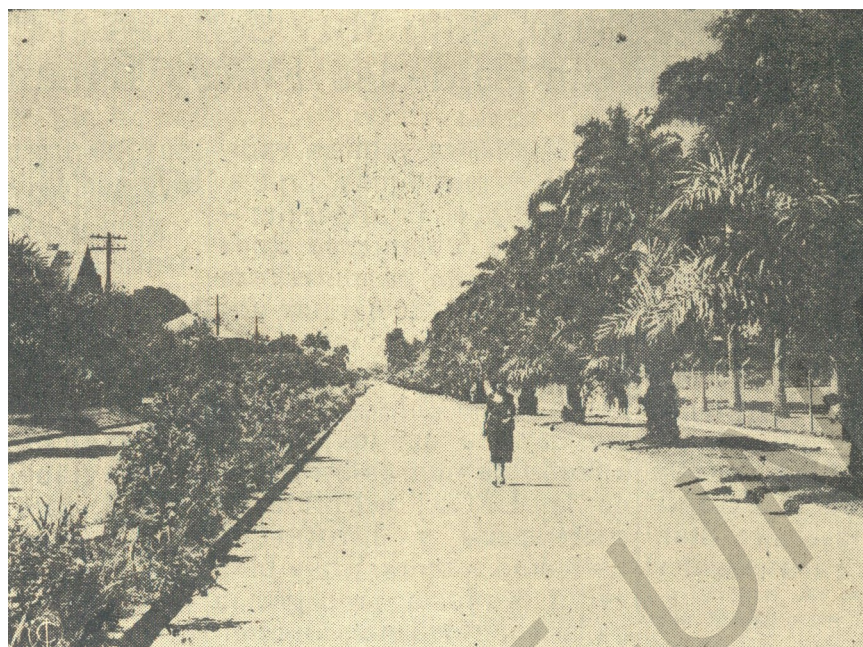
Boulevard 15 de Septiembre que extiende su belleza como un paseo al cual sólo le faltan las baquetas y la luz para convertirse en un punto de irresistible atracción.
