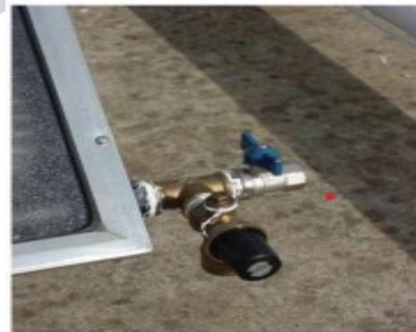
Figura No.10 Esquema típico de instalación de válvulas de presión y temperatura
