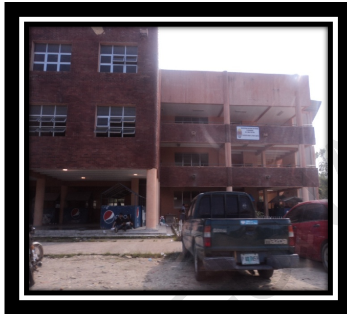
Instalaciones del Telecentro de Puerto Cortés
