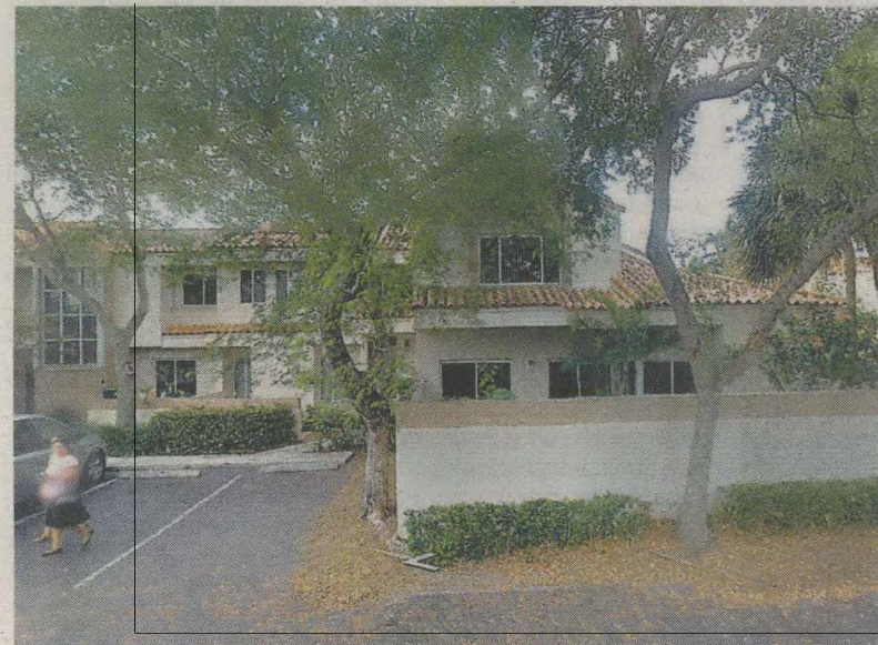
Fachada del complejo multifamiliar donde queda situada la casa de Michelle Rojas en Miami.
