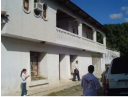
Edificio donde actualmente funciona la Alcaldía Municipal
