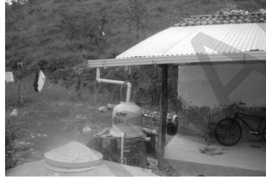
Sistema de captación de agua pluvial en su conjunto.
