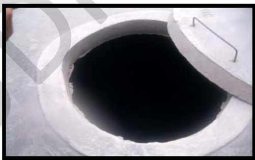
VISTA FRONTAL; TANQUES DE ALMACENAMIENTO.
