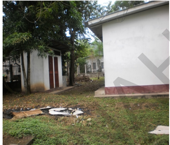
Baños y pila detrás del centro de Salud
