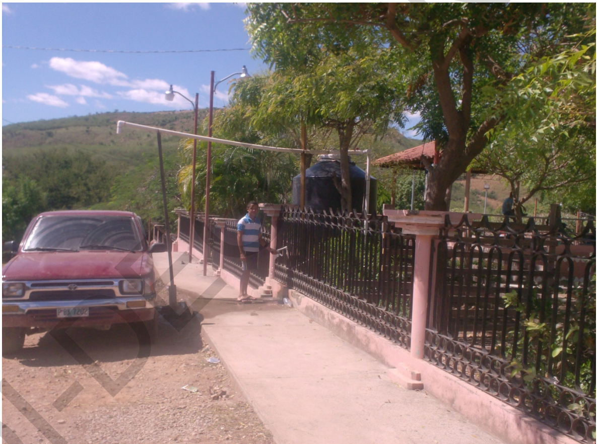
Imagen del sistema de abastecimiento público de agua en Liure, El Paraíso. Fuente propia Octubre 2011
