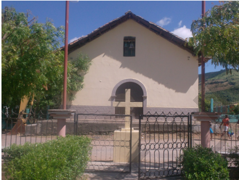
Fotografía 6 Iglesia Católica San Antonio de Liure
