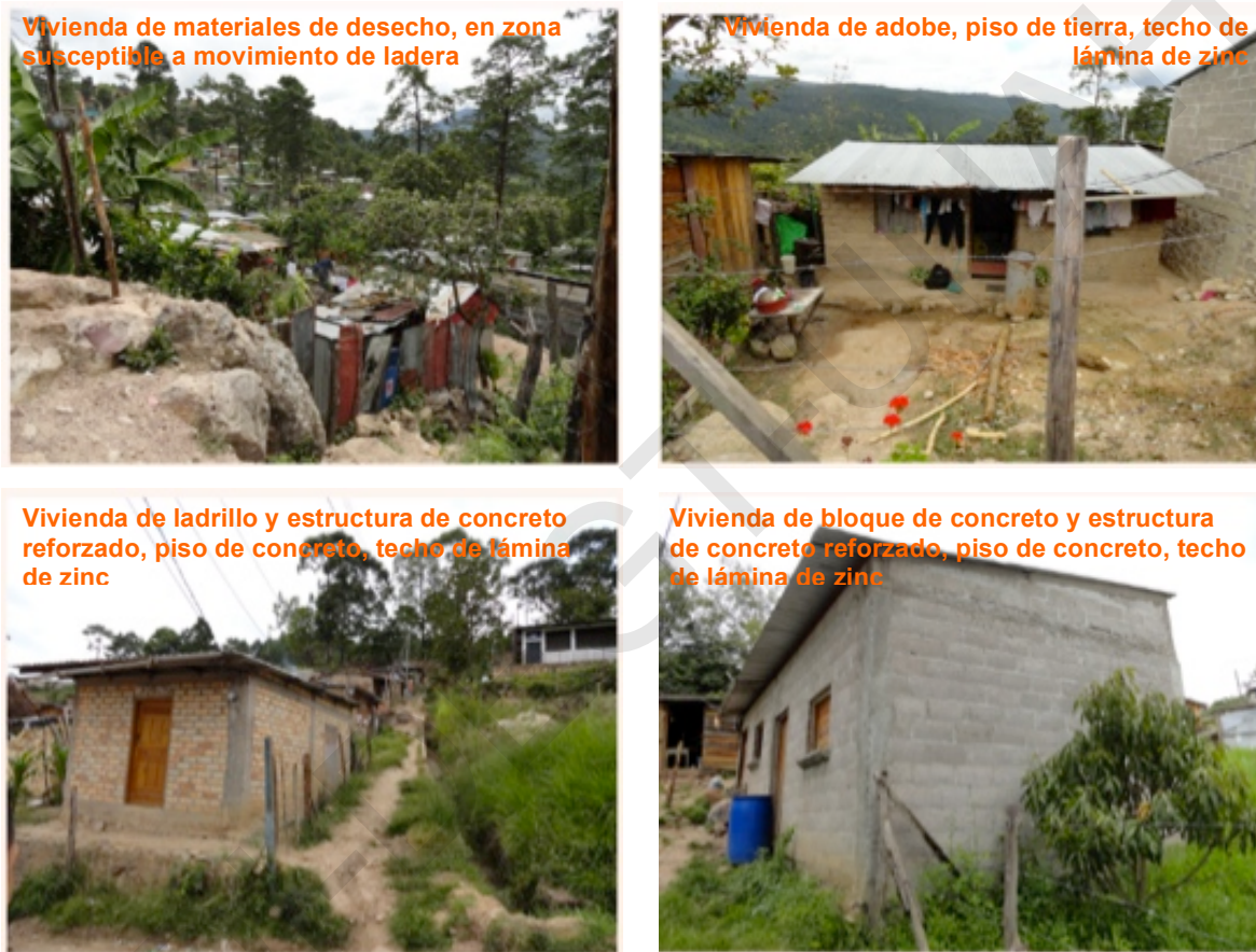
Fig. 4.14 Viviendas auto gestionadas
