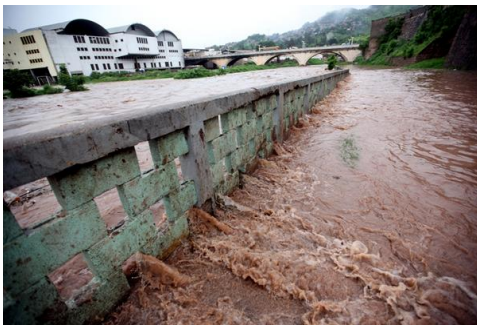
Las aguas del río Choluteca inundaron la calle ubicada detrás del antiguo Palacio Presidencial, en pleno centro de Tegucigalpa. Fuente: Diario El Herald, edición electrónica, 30 de mayo de 2010
