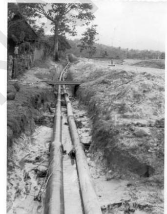
Ilustración 24: Instalación de Red de Agua Potable
