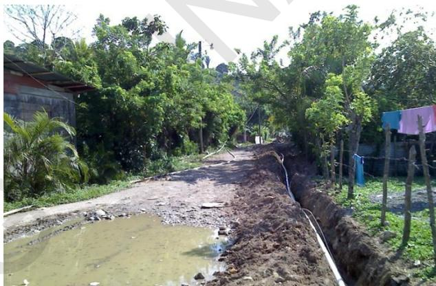
Ilustración 53: Proceso de instalación del sistema de agua potable en la Col. Las Delicias "2008"
