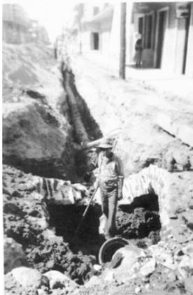
Ilustración 23: Instalación de Red de Alcantarillado Sanitario en el centro de la ciudad
