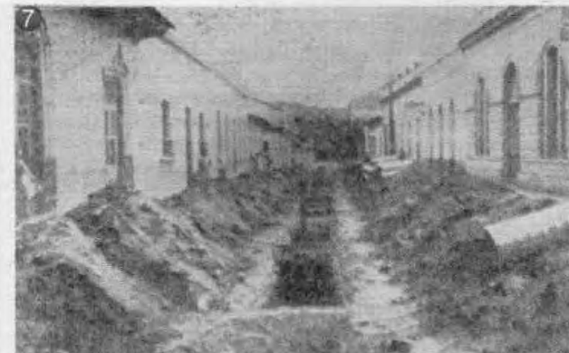
Trabajos de infraestructura en la Paz Barahona cerca del parque
