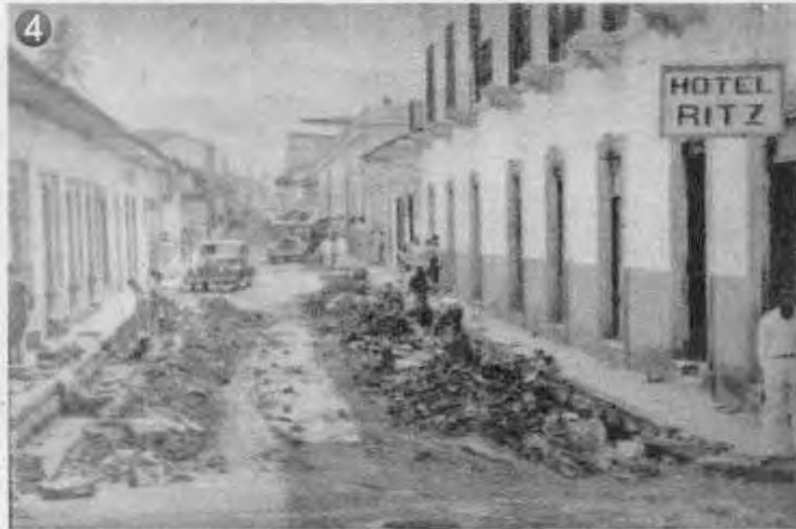
Trabajos de construcción de bordillos y aceras en una de las calles céntricas de Tegucigalpa todavía operaba el Hotel Ritz, donde hoy está el hotel Prado.
