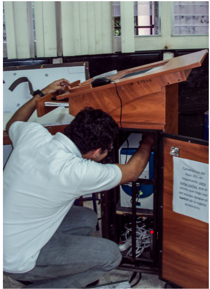
Figura # 6 Labores de Instalación.
