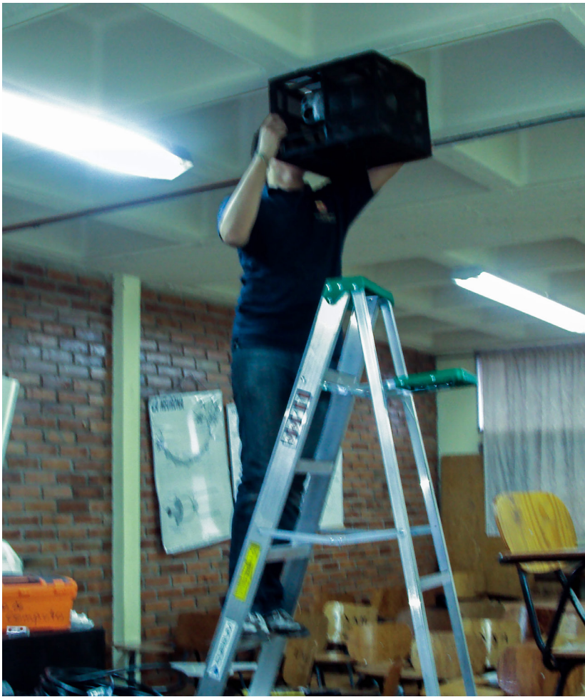
Figura # 5 Labores de Instalación.
