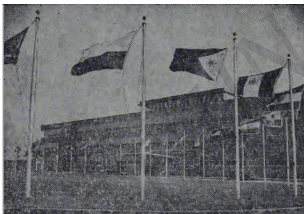
LOS TRES PISOS PRINCIPALES DE LA ONU EN LAKE SUCCESS N. Y., OFICINAS SUPERIORES DE LAS NACIONES UNIDAS.
