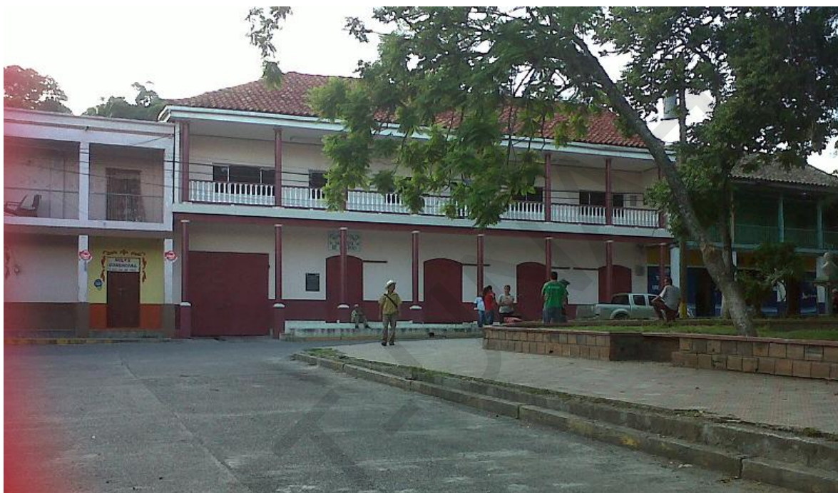
Vista Panorámica Palacio Municipal de San José de Colinas, Santa Bárbara
